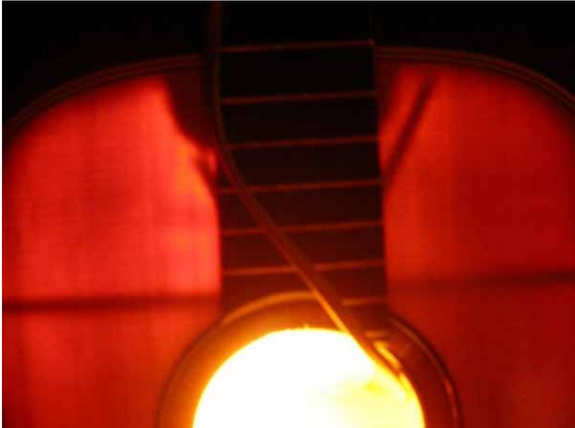
Abb. 3 oberer Deckenbereich durchleuchtet
