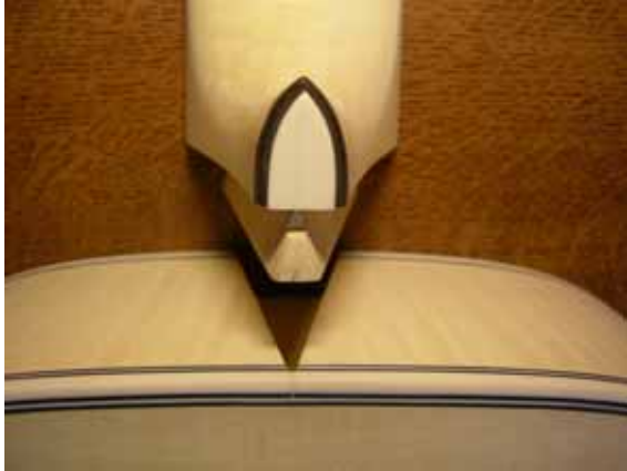
Abb. 39 Schwalbenschwanzverbindung
