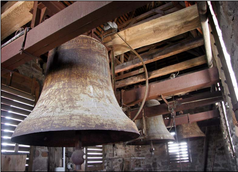
Kirche zu Klinga, Glockenstuhl mit den vier Eisenhartguss- glocken der Firma Schilling & Latter- mann, Apol- da/Morgenröthe-Rau- tenkranz 1967
